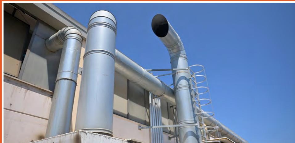
Per rendere migliori le condizioni di lavoro degli addetti è stato installato un impianto di aspirazione e filtrazione dell'aria presso le macchine ad iniezione.
